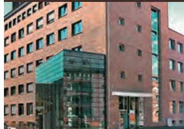
Büroobjekt Brixx, Frankfurt
